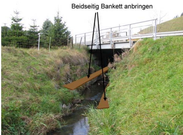
Foto 49-1: Gewässerdurchlass Seewag Kantonsstrasse K11 bei Unter-Marchstei (Massnahme GD1)
