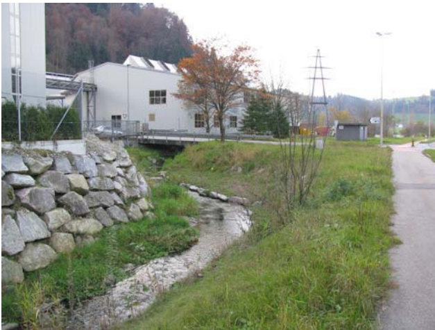
Foto 49-9: Gewässerdurchlass der Seewag im Bereich des Kronospan-Areals, Massnahme GD8: Anpassen der bestehenden Bankette.
