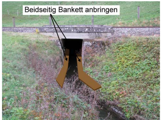
Foto 49-6: Gewässerdurchlass Seewag bei Bahnlinie im Gebiet Under-Marchstei (Massnahme GD5)
