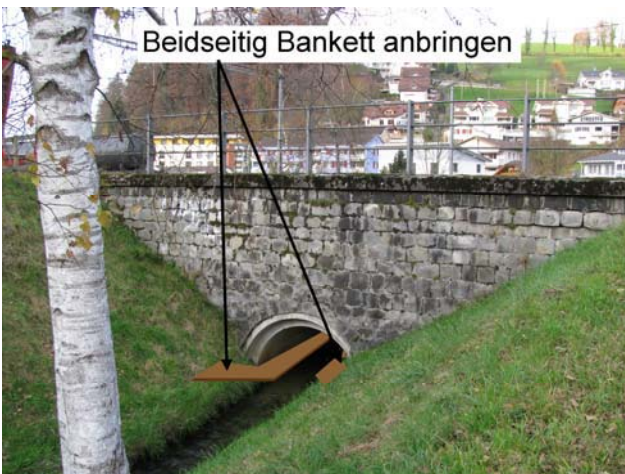
Foto 49-7: Gewässerdurchlass Seewag bei Bahnlinie SBB in der Siedlung Menznau (Massnahme GD6)
