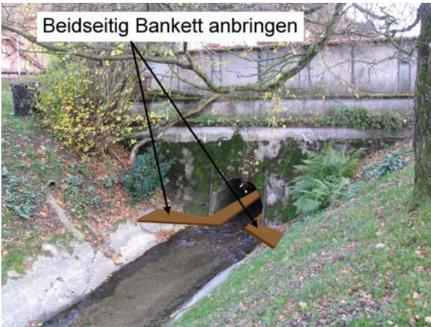
Foto 49-3: Gewässerdurchlass Seewag bei der Strasse Menznau-Geiss (Massnahme GD3)
