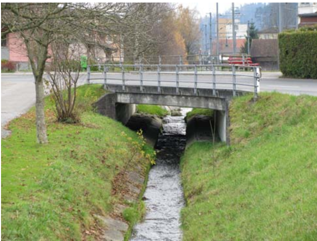
Foto 49-5: Gewässerdurchlass Seewag bei Herrenwaldstrasse, Massnahme GD4: in heutigem Zustand belassen.
