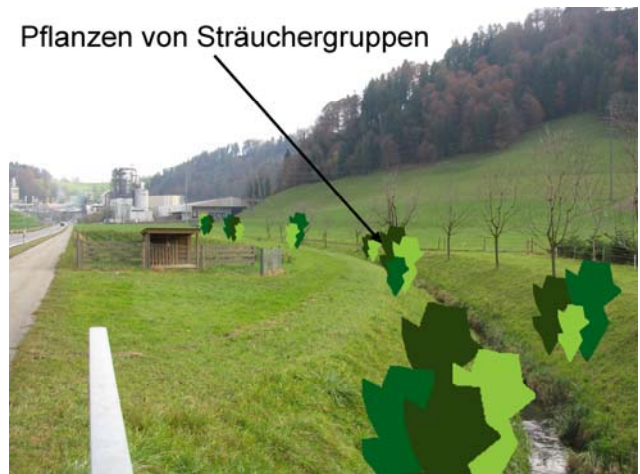
Foto 49-14: Seewag zwischen Kronospan-Areal und dem Gebiet Under-Marchstei (Massnahme VS2)
