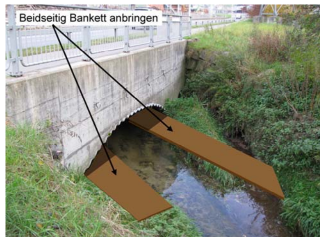
Foto 49-2: Gewässerdurchlass Seewag Kantonsstrasse K11 bei Kronospan-Areal (Massnahme GD2)
