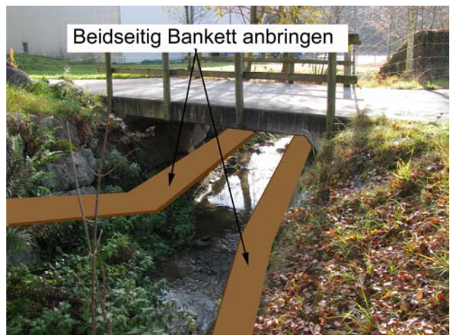
Foto 50-12: Gewässerdurchlass Schwarzenbach im Industriegebiet Hackerüti (Massnahme GD3)
