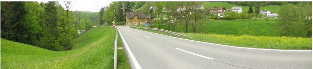
Foto 50-1: Kantonsstrasse K34 im Bereich des Gewässerdurchlasses vor Wolhusen; Blickrichtung Südwesten
