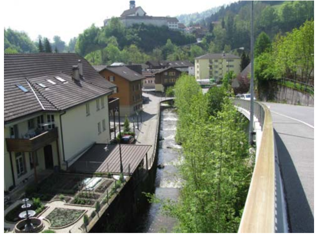
Foto 50-15: Blick von der Brücke auf den stark verbauten Bach
