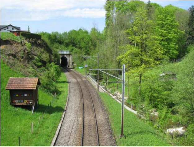
Foto 50-14: Blick von der Brücke auf die Eisenbahnlinie
