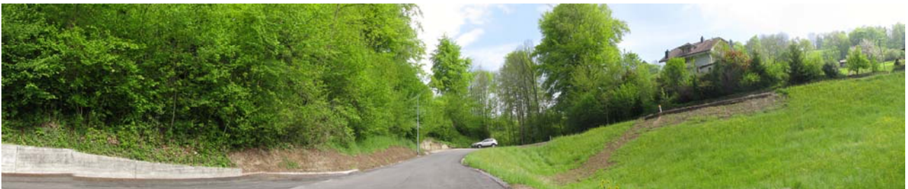
Foto 50-7: Strasse unterhalb des Waldstücks; ansteigende Mauer links im Bild bildet ein Hindernis; Bach ist nach Durchlass eingedolt (Wiese rechts im Bild)
