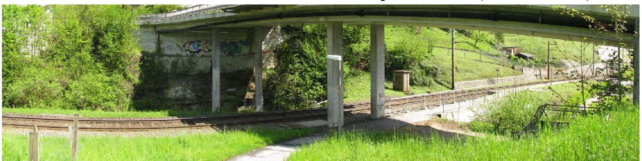
Foto 50-13: Brücke über Eisenbahn und Gewässer; Grünstreifen entlang Eisenbahn vorhanden
