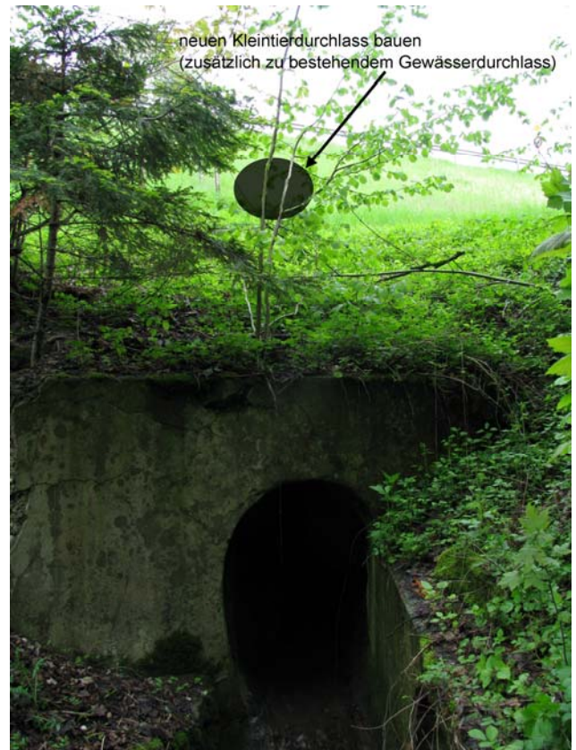
Foto 50-4: bestehender Gewässerdurchlass Schwarzenbach an der Kantonsstrasse K34, im Hintergrund zu bestockende Böschung und Standort des eventuell neu zuschaffenden Durchlasses (Massnahmen NB1 und VS1)
