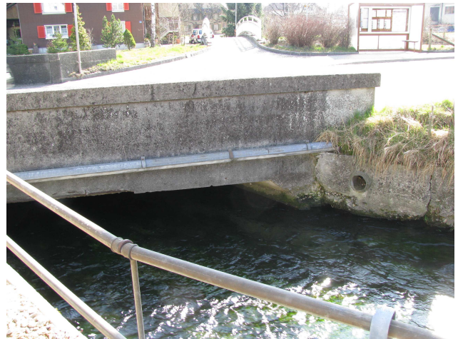
Foto 51-4: Gewässerdurchlass Mülibach an der Kantonsstrasse K11 (Massnahme GD2: in heutigem Zustand belassen)
