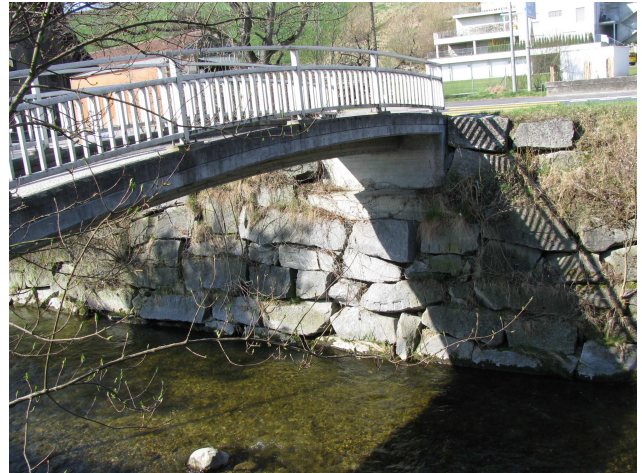
Foto 51-10: Gewässerdurchlass Wigger im Siedlungsgebiet Alberswil (Massnahme GD6: linkseitig Bankett anbringen)
