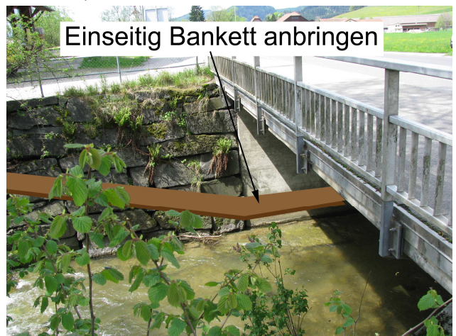
Foto 51-8: Gewässerdurchlass Wigger an der Kantonsstrasse K18 (Massnahme GD4)
