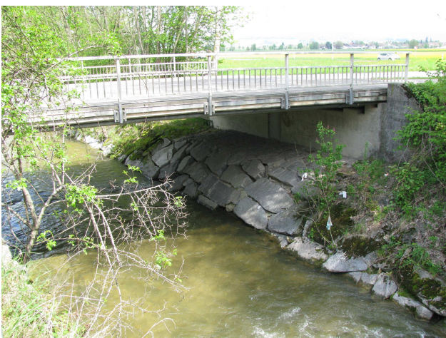
Foto 51-7: Gewässerdurchlass Wigger an der Kantonsstrasse K18 (einseitig Bankett vorhanden)
