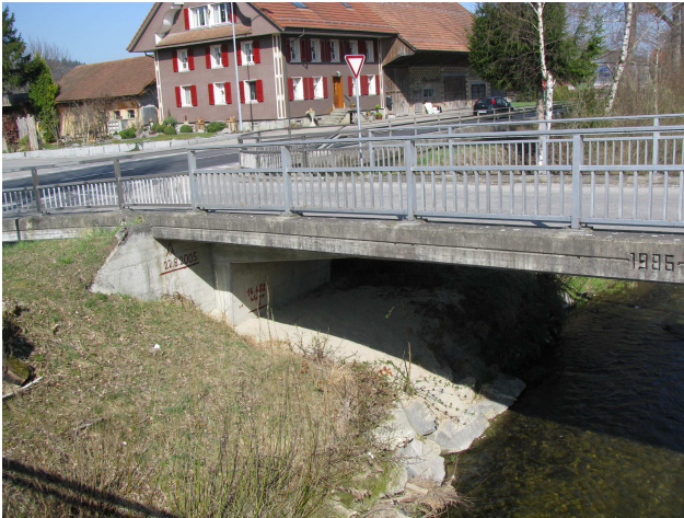
Foto 51-9: Gewässerdurchlass Wigger im Siedlungsgebiet Alberswil (Massnahme GD5: in heutigem Zustand belassen)
