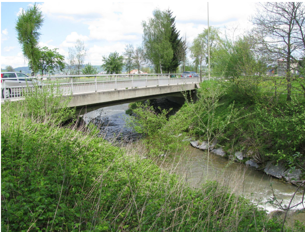
Foto 51-5: Gewässerdurchlass Wigger an der Kantonsstrasse K11
