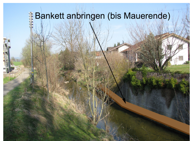
Foto 52-2: Mauer anschliessend an den Gewässerdurchlass Rot an der Kantonsstrasse K18 (Massnahme GD1)
