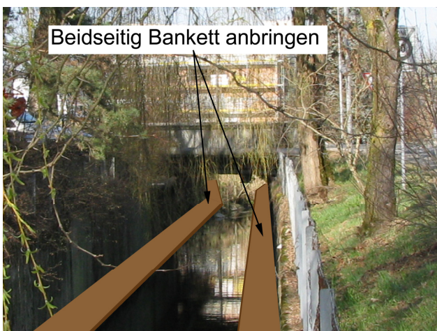
Foto 52-1: Gewässerdurchlass Rot an der Kantonsstrasse K18 (Massnahme GD1)
