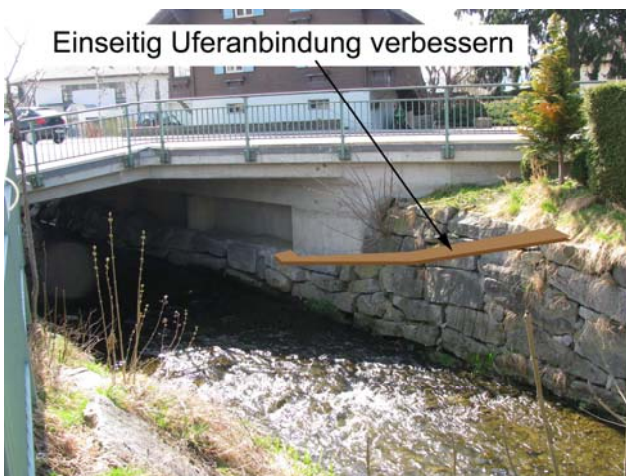
Foto 53-1: Gewässerdurchlass Rot an der Kantonsstrasse K12 (Massnahme GD1)
