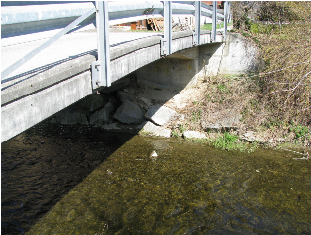
Foto 53-3: Gewässerdurchlass Rot am Rand der Gewerbe-/Industriezone Schutzmatte (Massnahme GD3: Durchlass in heutigem Zustand belassen)
