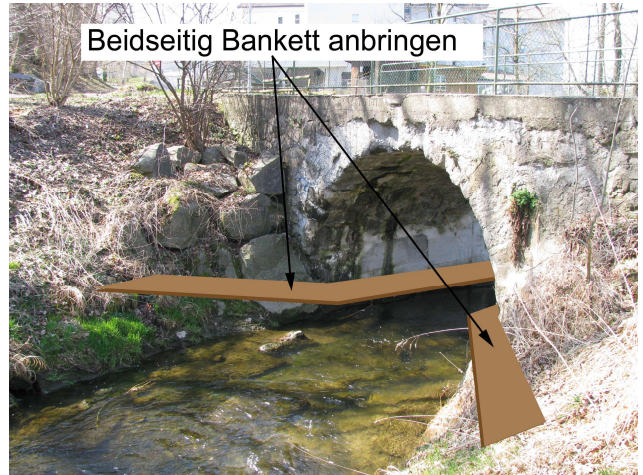
Foto 53-4: Gewässerdurchlass Rot nördlich des Gebiets Lindenhof (Massnahme GD4)
