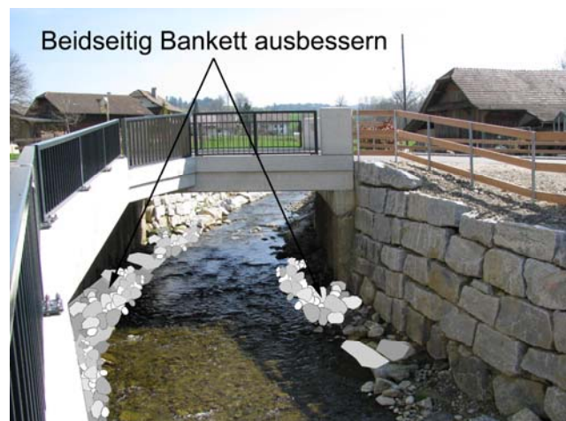
Foto 53-2: Gewässerdurchlass Rot an der Strasse Huebe-Innerdorf (Massnahme GD2)
