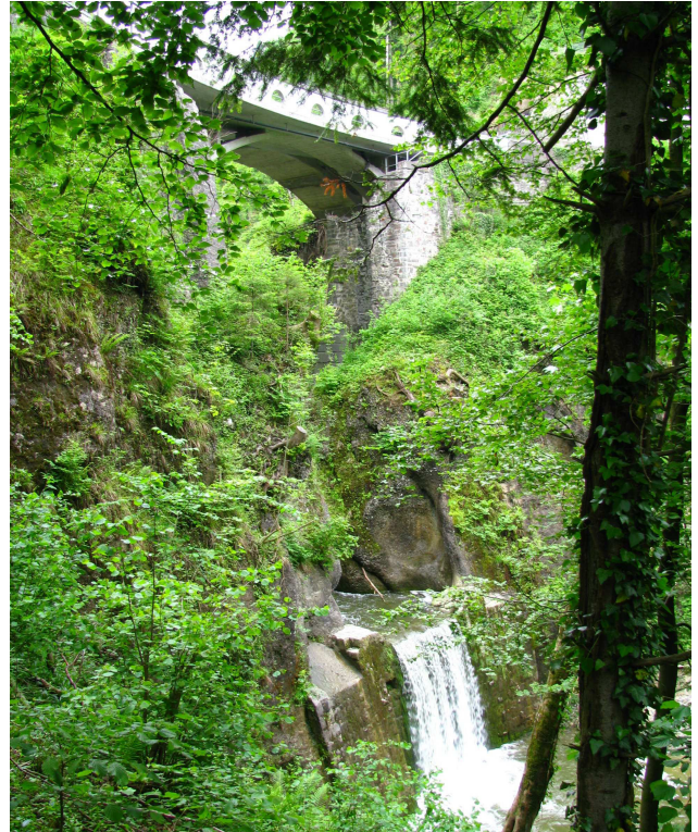
Foto 54-2: Renggbach mit hohem Absturz unterhalb der Strassenbrücke
