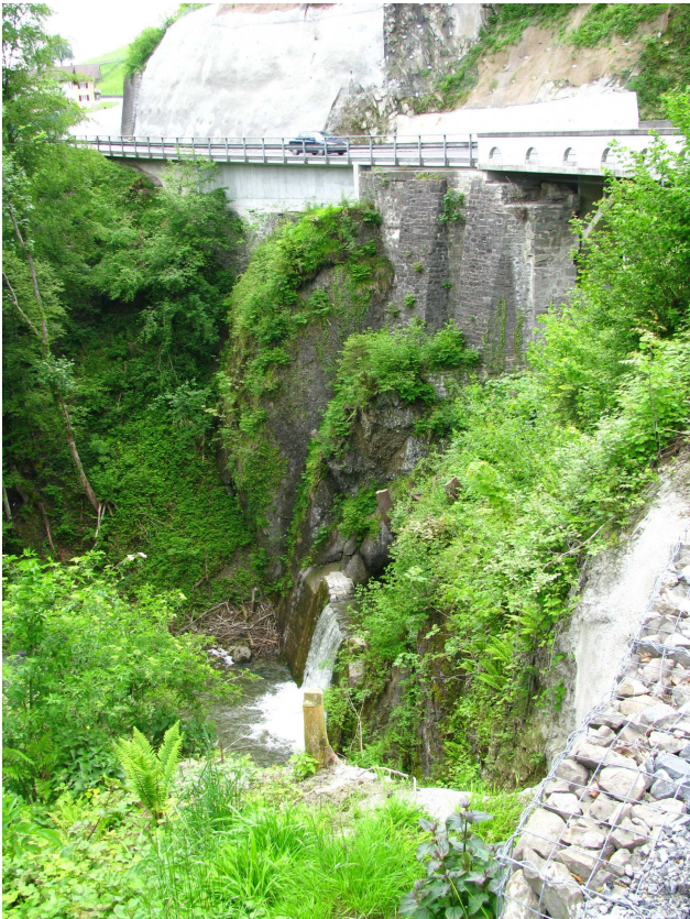
Foto 54-3: Situation östlich, unterhalb des Durchlasses
