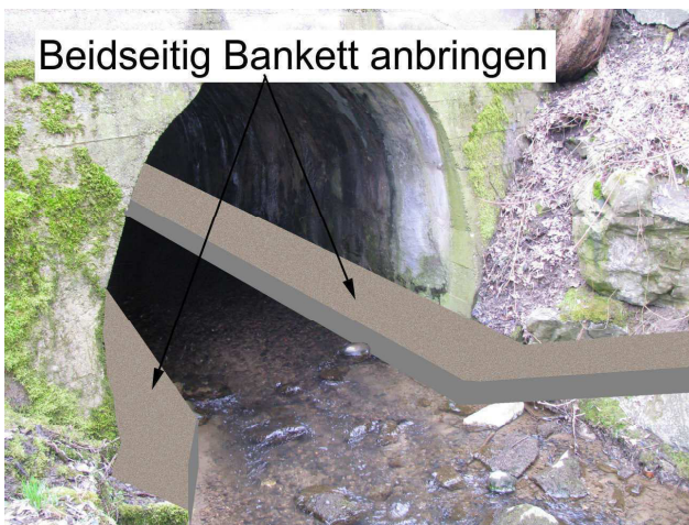
Foto 55-1: Gewässerdurchlass Sellenbodenbach an der Kantonsstrasse K13 (Massnahme GD1)
