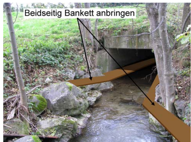
Foto 57-2: Gewässerdurchlass Hofbach beim Golfplatz (Massnahme GD2)
