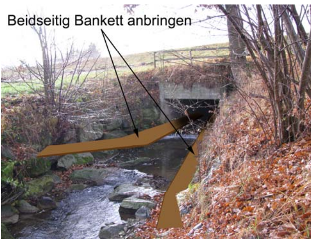
Foto 57-1: Gewässerdurchlass Hofbach beim Bauernhof Weiler Oberhof (Massnahme GD1)
