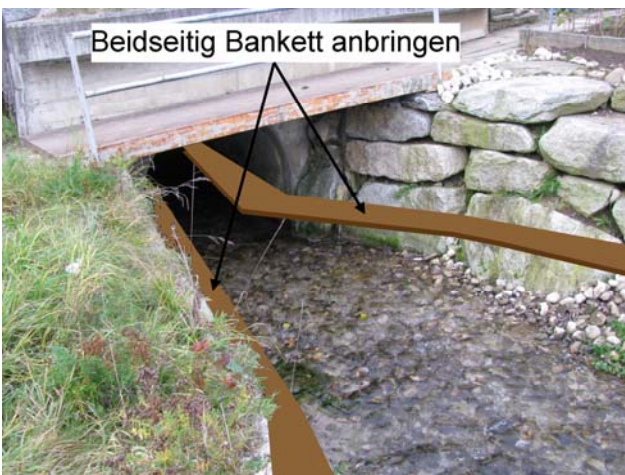
Foto 57-7: Gewässerdurchlass Hofbach bei der Bahnlinie Sursee – Nottwil (Massnahme GD6)
