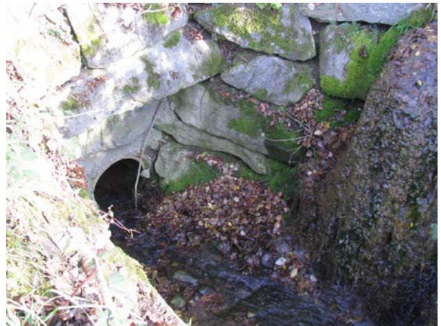
Foto 57-4: Gewässerdurchlass bei der Strasse Ränzligen – Sursee, Massnahme GD4: Durchlass in heutigem Zustand belassen, Massnahme GAU1: Ausstiegsmöglichkeiten für Kleintiere schaffen.
