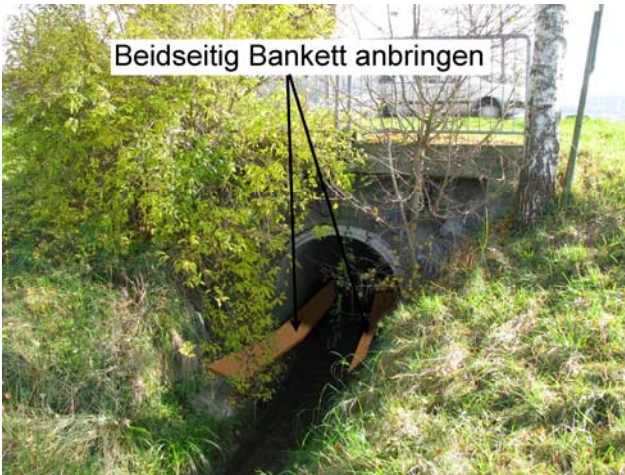
Foto 57-3: Gewässerdurchlass Bognauerbach bei Kantonsstrasse K18 (Massnahme GD3)
