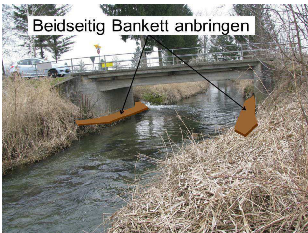
Foto 58-1: Gewässerdurchlass Suhre an der Strasse Knutwil – Büron (Massnahme GD1)
