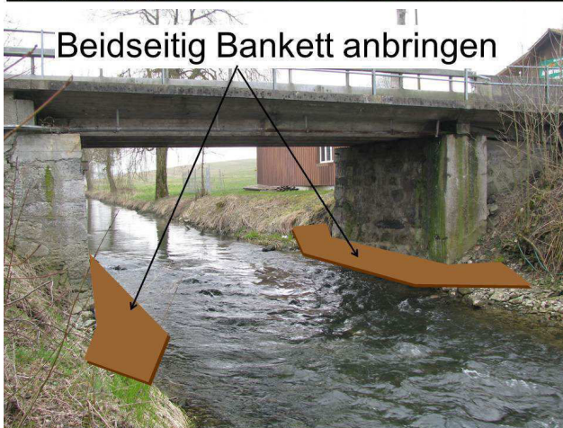
Foto 59-1: Gewässerdurchlass Suhre an der Kantonsstrasse K52 (Massnahme GD1)
