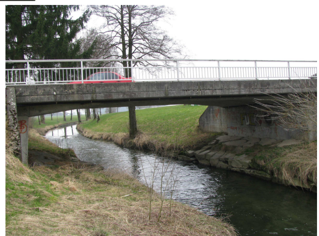
Foto 59-2: Gewässerdurchlass Suhre an der Kantonsstrasse K51 (Massnahme GD2: in heutigem Zustand belassen)
