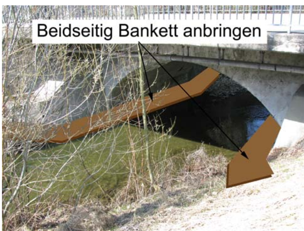
Foto 60-1: Gewässerdurchlass Rot an der Kantonsstrasse K42 (Massnahme GD1)
