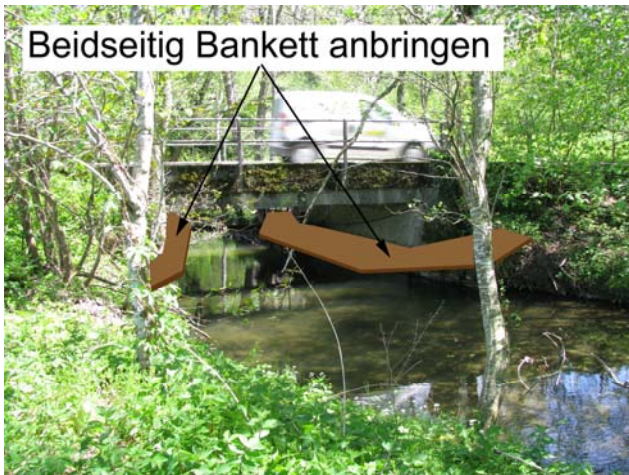
Foto 60-3: Gewässerdurchlass Rot an der Strasse St.Urban – Sängi (Massnahme GD3)
