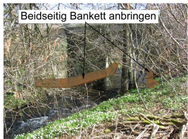
Foto 60-2: Gewässerdurchlass Rot an der Strasse St. Urban - Vorderwald (Massnahme GD2)
