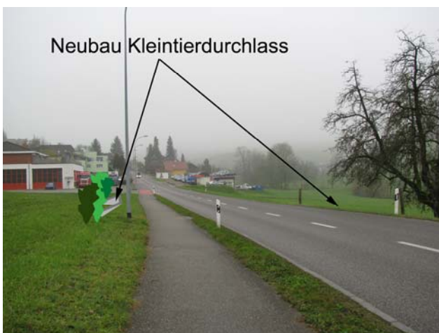
Foto 61-1: Kantonsstrasse K42 im Bereich des neu-zubauenden Kleintierdurchlasses (Massnahme NB1)
