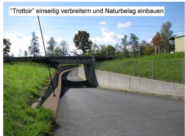
Foto 62-2: Unterführung bei der Bahnlinie (Massnahme UF1)
