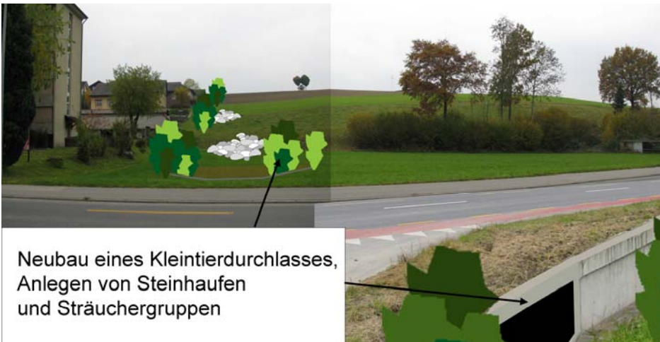
Foto 62-3: Kantonsstrasse K11: Massnahmen NB2 und VS2
