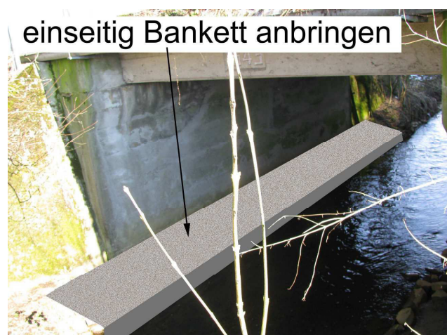
Foto 63-2: Gewässerdurchlass Ron an der Strasse Wauwil – Ettiswil (Massnahme GD1)
