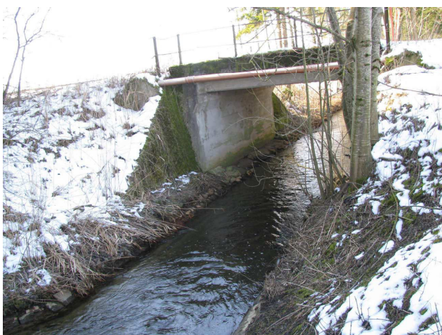
Foto 63-1: Gewässerdurchlass Ron an der Strasse Wauwil – Ettiswil (linksseitig Bankett vorhanden)
