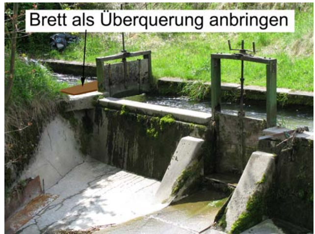
Foto 66-10: Gewässerdurchlass und Wehr der Luthern im Siedlungsgebiet Zell (Massnahme GD8)
