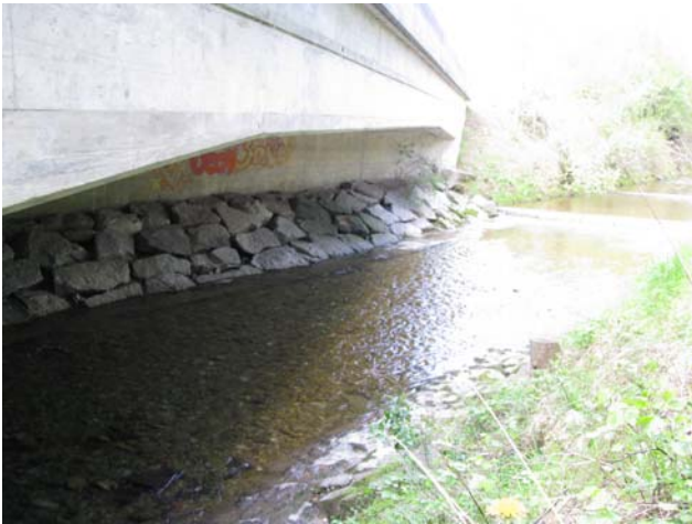
Foto 66-3: Gewässerdurchlass Luthern an der Kantonsstrasse K18 (Massnahme GD3: Durchlass in heutigem Zustand belassen)
