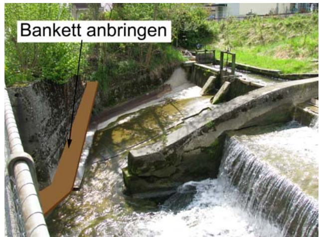
Foto 66-12: Gewässerdurchlass und Wehr der Luthern im Siedlungsgebiet Zell (Massnahme GD8)
