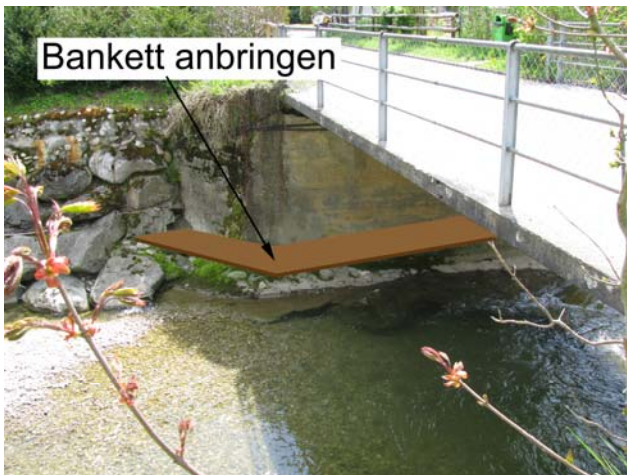
Foto 66-11: Gewässerdurchlass und Wehr der Luthern im Siedlungsgebiet Zell (Massnahme GD8)
