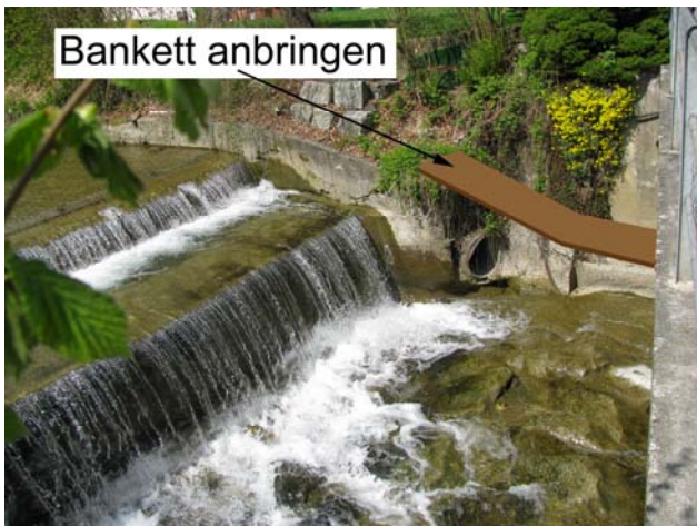
Foto 66-13: Gewässerdurchlass und Wehr der Luthern im Siedlungsgebiet Zell (Massnahme GD8)
