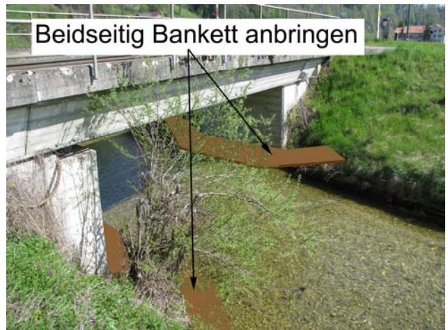
Foto 66-8: Gewässerdurchlass Luthern an der Bahnlinie SBB (Massnahme GD6)
