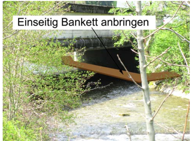
Foto 66-4: Gewässerdurchlass Luthern an der Kantonsstrasse K18 (Massnahme GD4)
