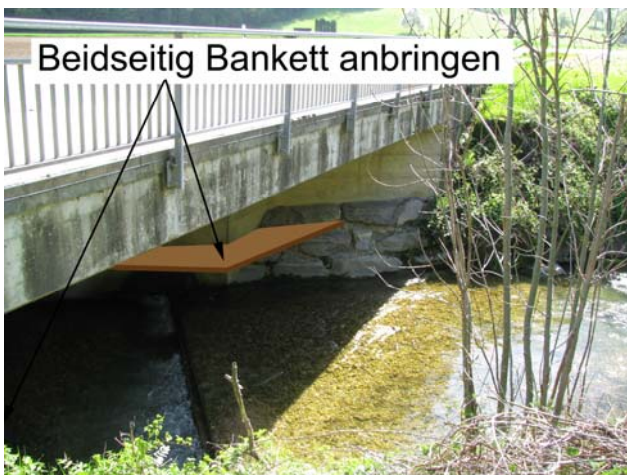
Foto 66-1: Gewässerdurchlass Luthern an der Kantonsstrasse K41 (Massnahme GD1)
