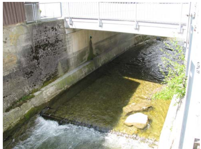
Foto 66-6: Gewässerdurchlass Luthern an der Kantonsstrasse K42, beidseitig stellenweise schmales Bankett vorhanden
