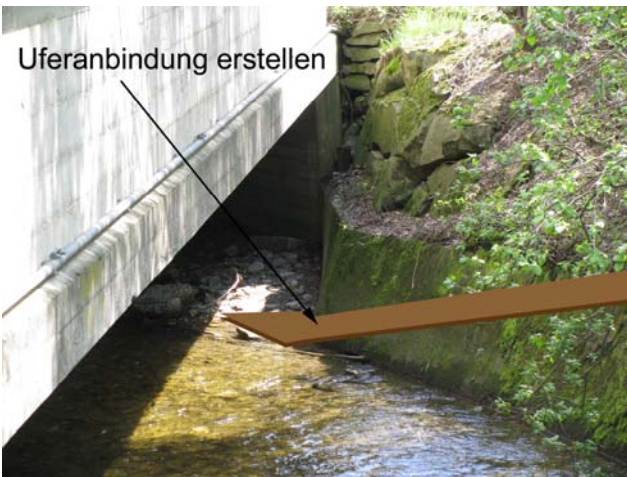
Foto 66-5: Gewässerdurchlass Luthern an der Kantonsstrasse K18 (Massnahme GD4)
