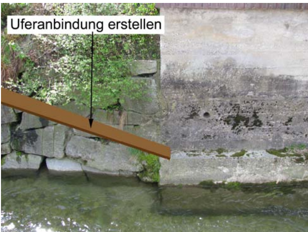
Foto 66-7: Gewässerdurchlass an der Kantonsstrasse K42 (Massnahme GD5)
