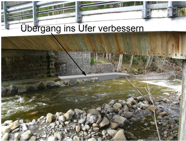
Foto 67-3: Gewässerdurchlass Rotbach an der Kantonsstrasse K36 (Massnahme GD1)
