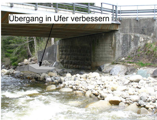
Foto 67-1: Gewässerdurchlass Rotbach an der Kantonsstrasse K36 (Massnahme GD1)
