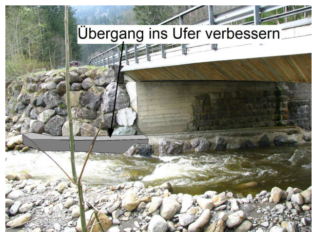
Foto 67-2: Gewässerdurchlass Rotbach an der Kantonsstrasse K36 (Massnahme GD1)
