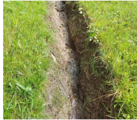
Abbildung 5: erodierender Graben (links) und nicht fachgerecht unterhaltener Graben (rechts)
